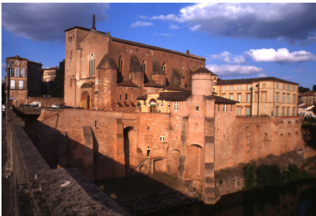
Gaillac (église et murs des berges)
